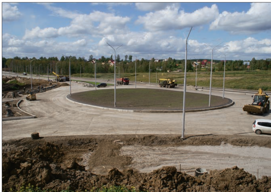
Кольцевая развязка на этапе окончания строительства
