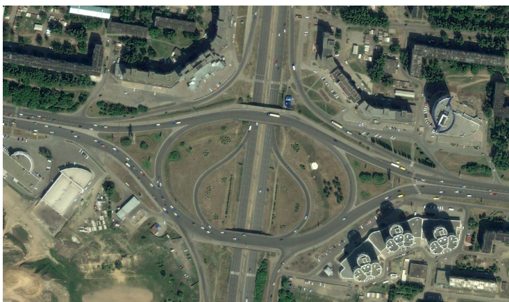
Рис. 7. Кольцевое пересечение в разных уровнях на пересечении улиц Малахова и Павловского тракта в г. Барнаул, выполненное по сжатому усовершенствованному типу распределительного кольца с двумя путепроводами
